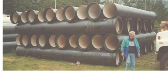
Vantaggi: massima limitazione del materiale di ancoraggio, perché i tubi alle estremità si trovano automaticamente ancorati dai bicchieri alternati dello strato inferiore
