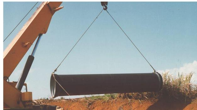
✓ Utilizzare dei ganci di forma appropriata, diversi per il bicchiere e per l'estremo liscio, rivestiti internamente di una protezione in gomma
