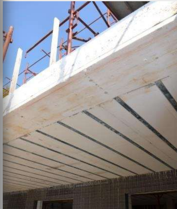
Solaio con doghe metalliche
