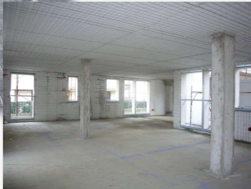
Soffitto con rete porta-intonaco
