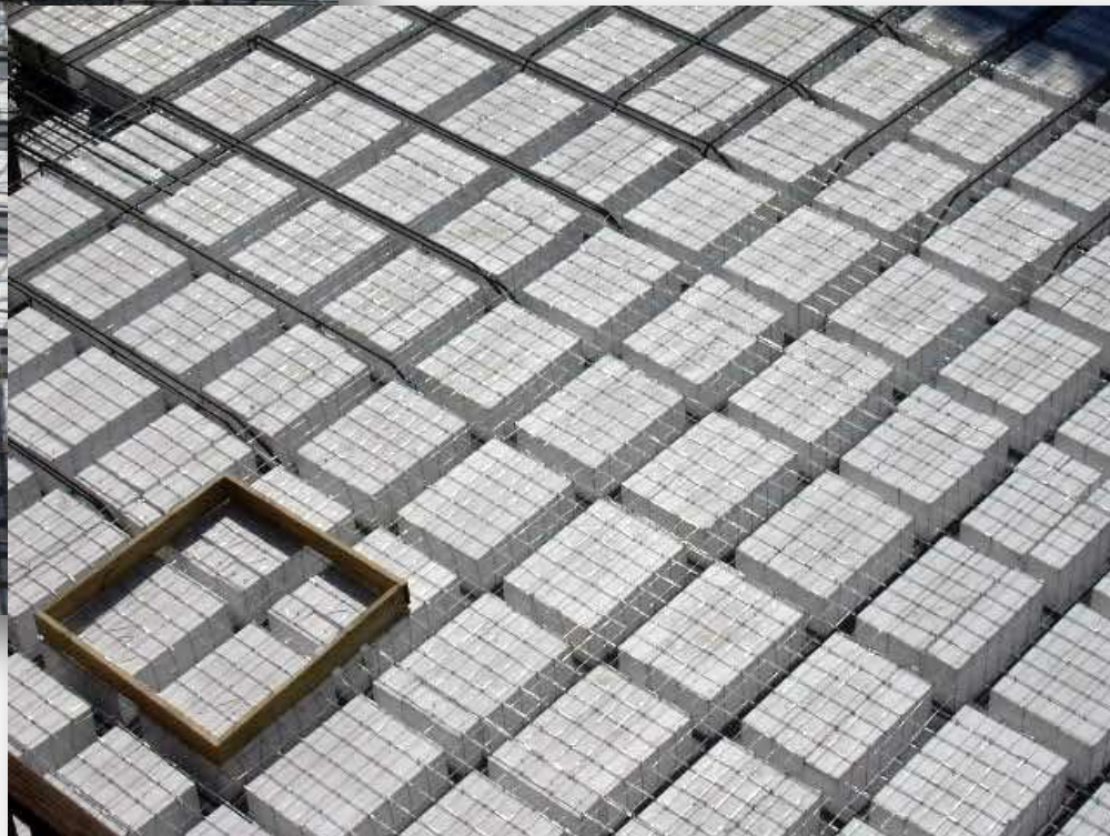
Solaio bidirezionale ad armatura incrociata
