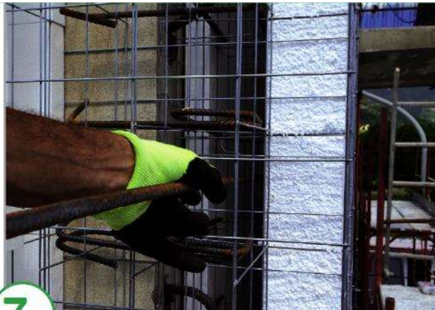
Posa delle armature orizzontali e verticali
