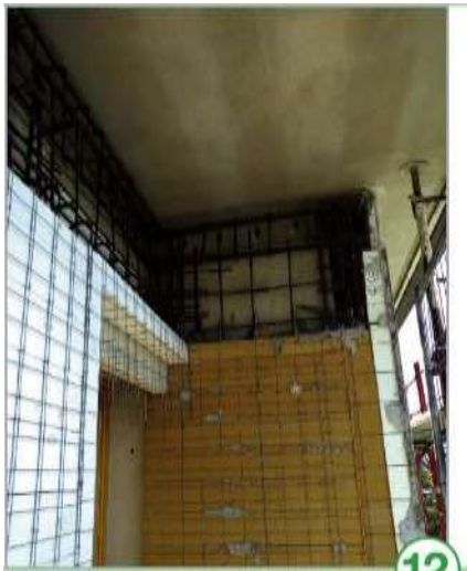
Realizzazione del cordolo in sommità
