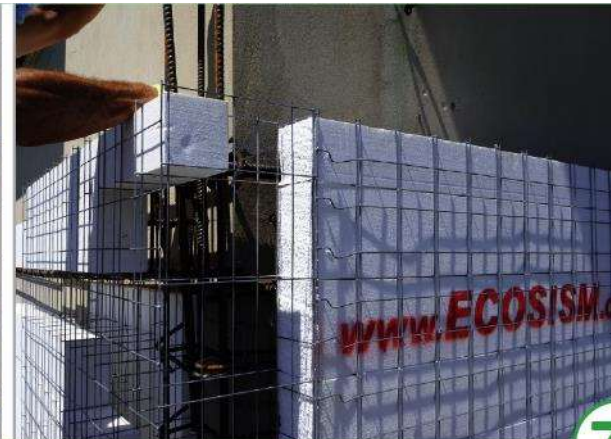
Posa delle armature orizzontali e verticali
