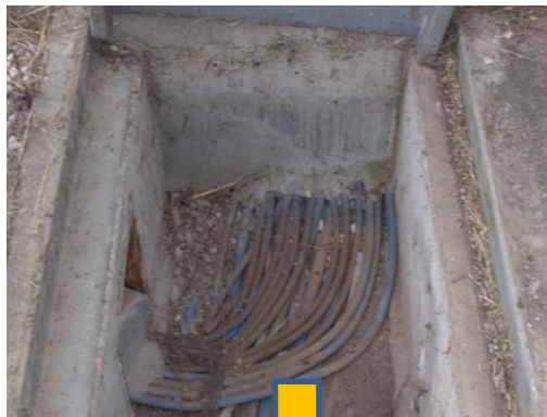
Cavi fissati nel cemento
