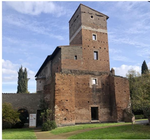
B) Casale di Santa Maria Nova, realizzato in più fasi a partire dal Medioevo sulle muraure antiche di una cisterna romana.
