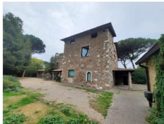
Vista della facciata di ingresso
