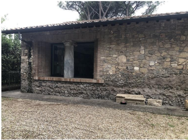
A) Villino di Capo di Bove: edificio novecentesco realizzato con materiali di recupero su un'antica cisterna romana, visibile nella muratura in selce alla base della costruzione.
