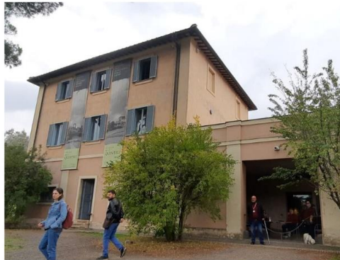
D) Villa dei Quintili: casale principale realizzato nei primi del '900, nel periodo dei Torlonia.
