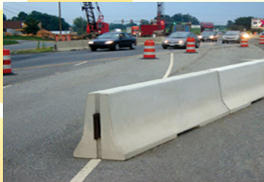
Zone di cantiere
