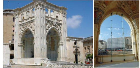
Sostituzione vetrate edificio storico "Il Sedile" di Lecce. Fonte architectureonweb
