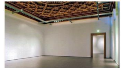
Finte pareti per impianto VMC, sale espositive di Palazzo Grassi, Venezia. Fonte Aicarr
