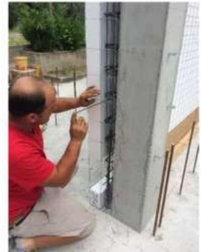
Figura 4.18. Posa dell'armatura
