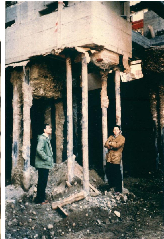
Vista delle sottofondazioni durante varie fasi di scavo
