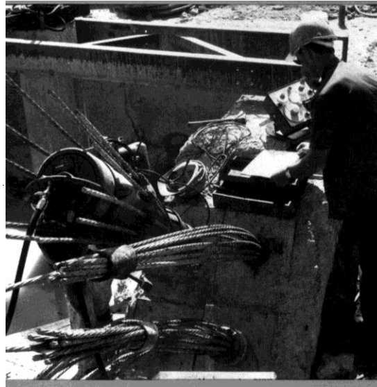
Mise en tension d'un tirant
