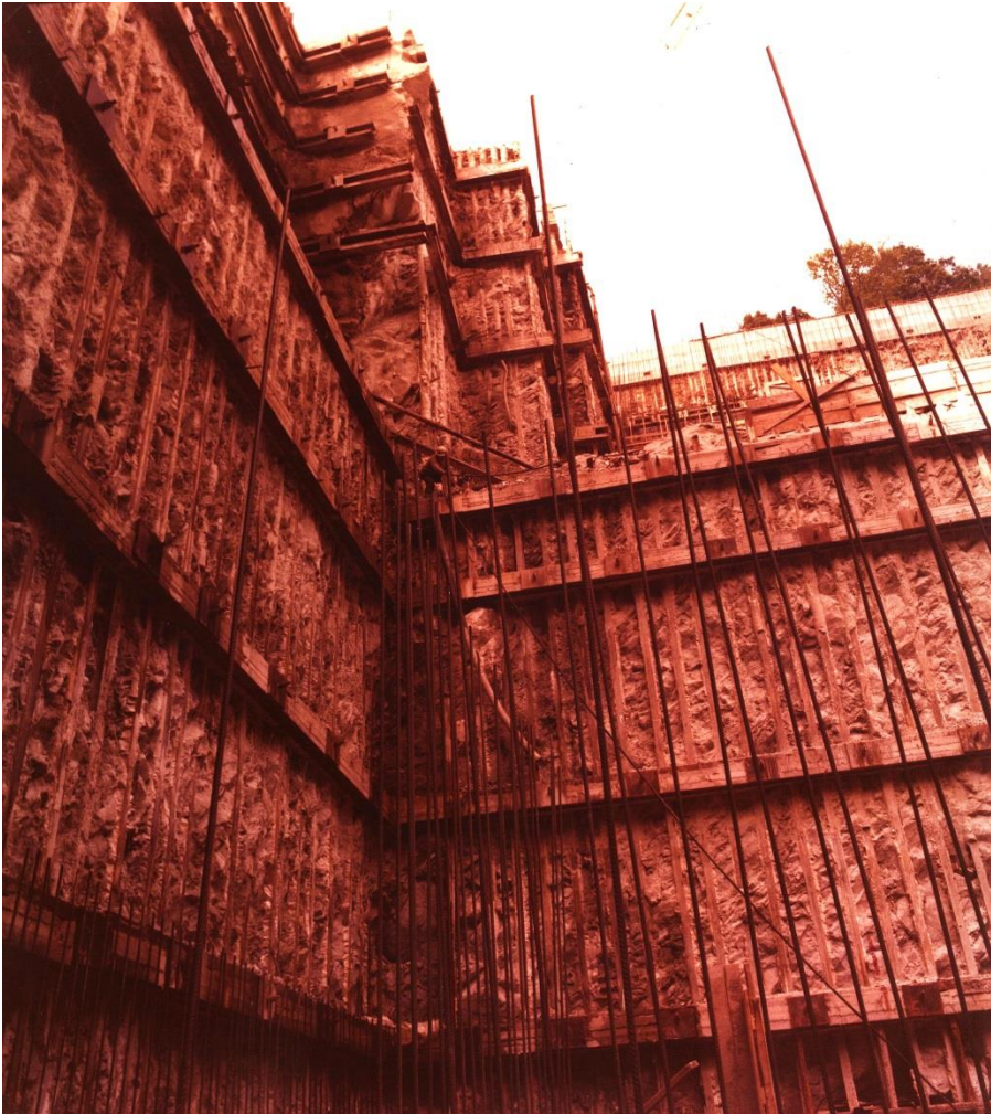
ENEL - Nuova centrale idroelettrica di Orichella - Sila. Scavo di 40 m per aumento del salto idraulico ed alloggiamento turbine. RODIO / Garrasi 1973 - 75
