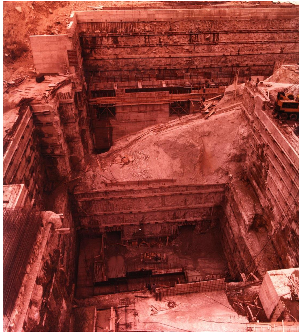
ENEL - Nuova centrale idroelettrica di Orichella - Sila. Scavo di 40 m per aumento del salto idraulico ed alloggiamento turbine. RODIO / Garrasi 1973 - 75
