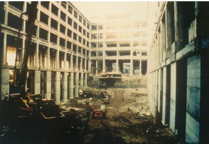
CENTRO CONGRESSI LINGOTTO (TORINO) - SOTTOFONDAZIONI PER GLI SCAVI DELLA MAIN-HALL - Renzo Piano - Vitone & Associati - Garrasi 1991-92
