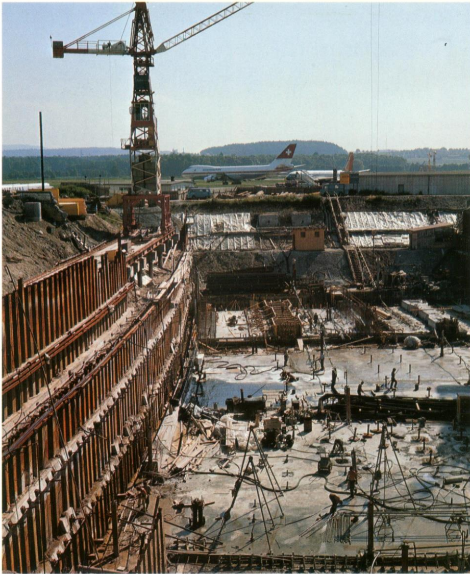
PALANCOLATE METALLICHE UTILIZZATE COME OPERA DI SOSTEGNO
