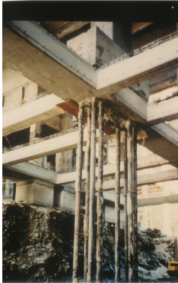
Vista delle sottofondazioni durante varie fasi di scavo
