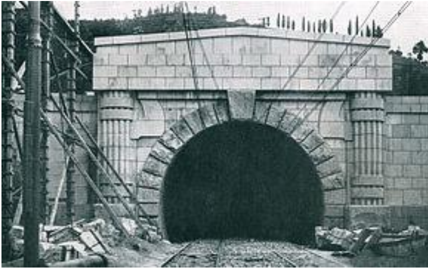
GRANDE GALLERIA DELL'APPENNINO (1923-1934 L = 18.507 km)
