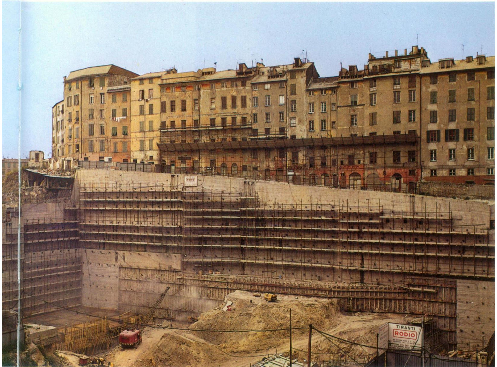
Genova Madre di Dio. Scavo di 34 m in argille, argilliti, blocchi calcarei e calcare fratturato. Impresa RODIO - 1975
