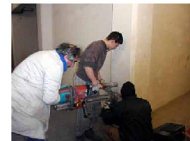
CAROTATURE INTERNE PIANO CANTINA PRECEDUTE DA ANALISI PACOMETRICA PER INDIVIDUAZIONE FERRI DI ARMATURA
