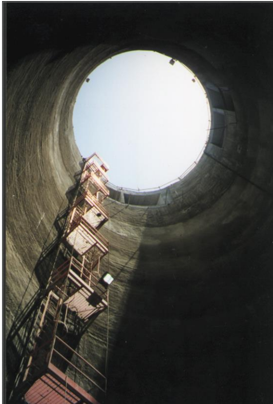
Un'immagine del pozzo ascensori a scavi ultimati. Il rivestimento sia provvisorio che definitivo delle pareti è stato realizzato mediante getto di spritz beton fibrinforzato, a seguito di un accurato mix-design che garantisce il dovuto grado di finitura della superficie esterna.
