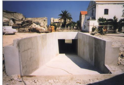
Le rampe di uscita dei trattori, prima delle opere di completamento architettonico.
