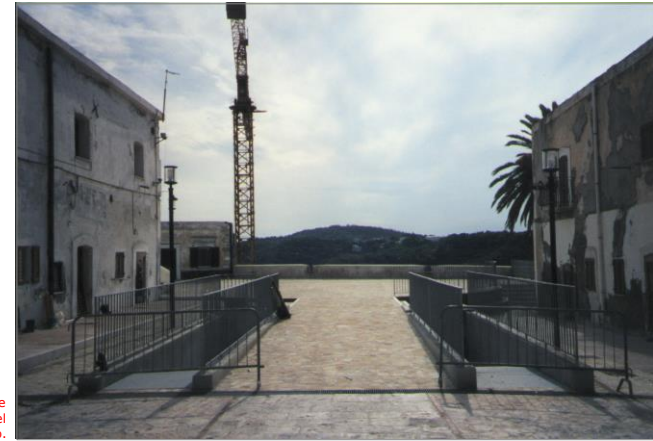
L'uscita delle due rampe pedonali, ben inserita nel contesto architettonico.
