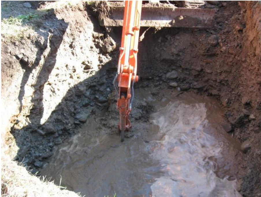
Realizzazione scavo: dimensioni 3 m x 4 m x h 3,50 m
