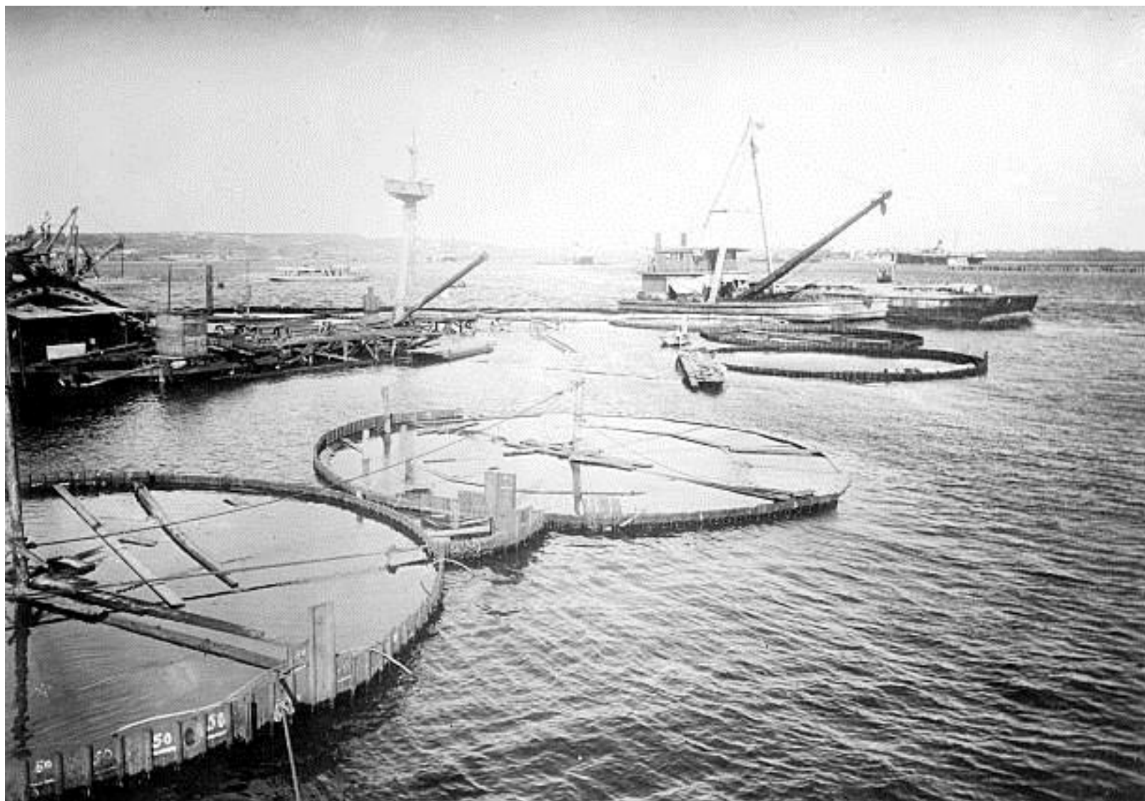
I COFFERDAM IN FASE DI REALIZZAZIONE – ALL'INTERNO IL RELITTO DELLA NAVE
