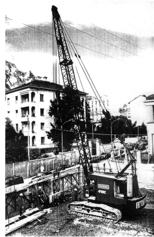
posizionamento in quota della testa pannello
