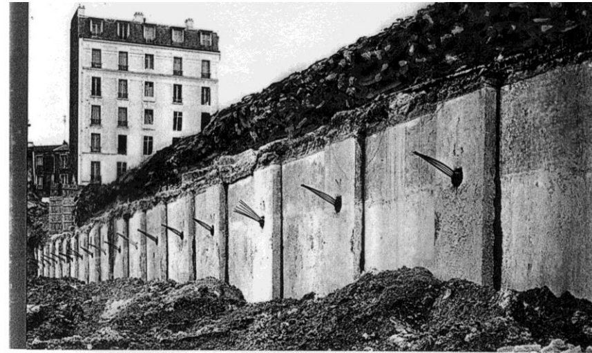
Paroi en cours de dégagement construite pour l'immeuble E.D.F. à ISSY-LES-MOULINEAUX.
