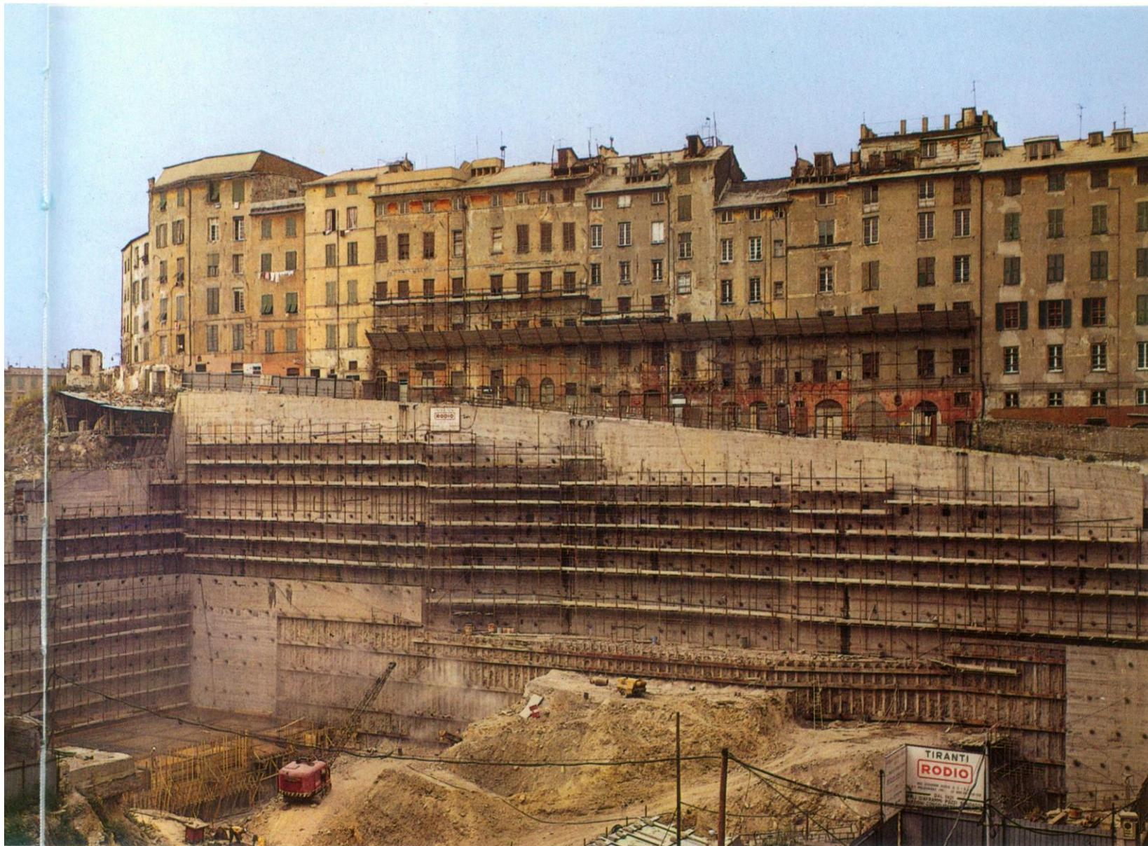
Genova Madre di Dio. Scavo di 34 m in argille, argilliti, blocchi calcarei e calcare fratturato.
