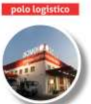
BARI PIATTAFONIMA LOGISTICA S.P. Bari-Modugno-Toritto 75-74/V
