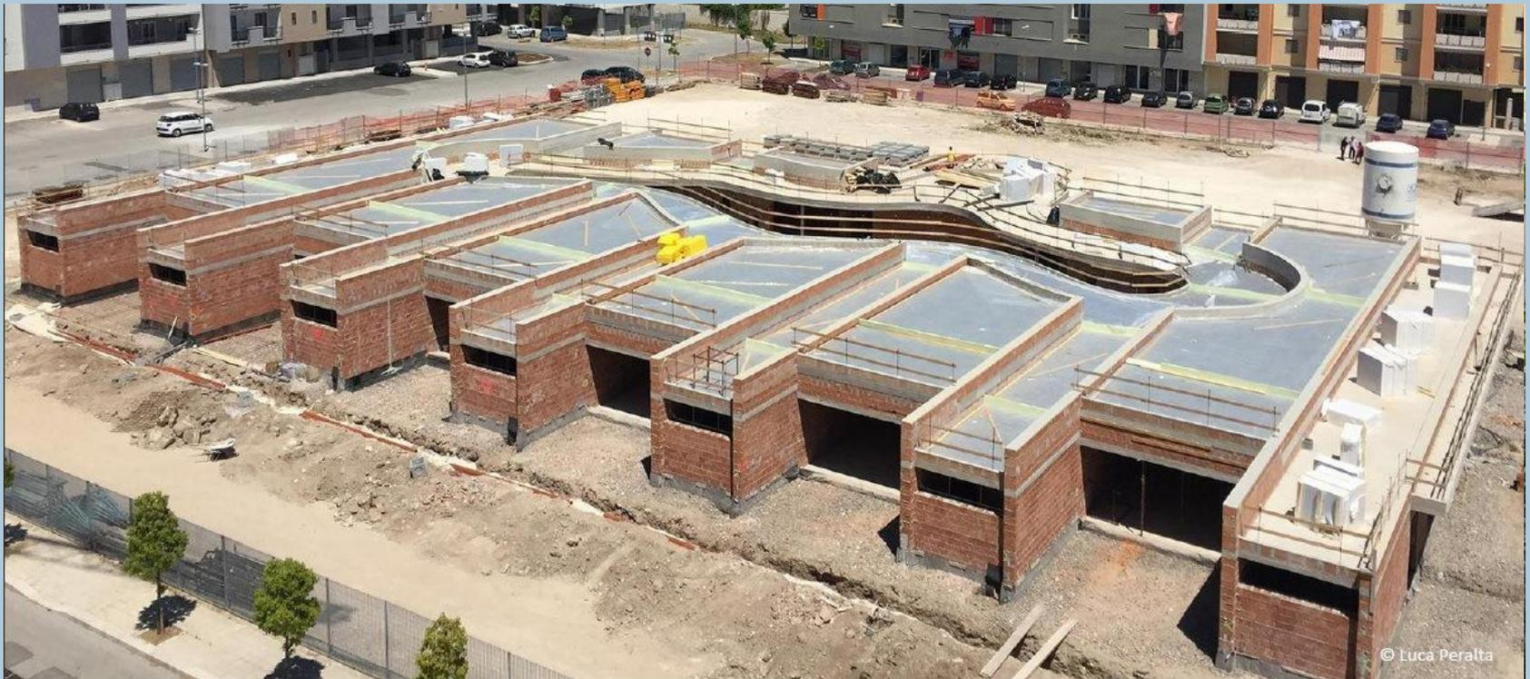
Setti portanti in muratura armata , costituita da blocchi in laterizio che inglobano barre di armatura verticale.
