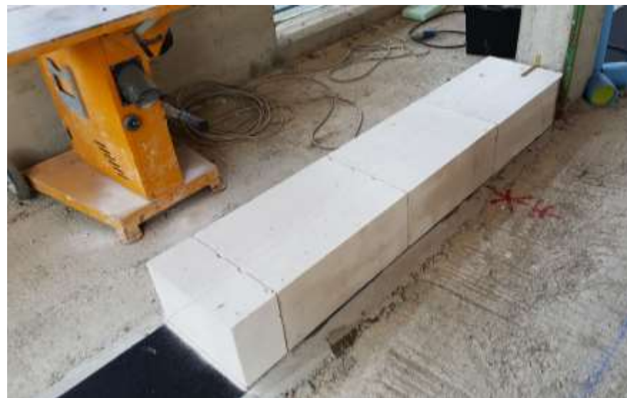
Posa della prima fila di blocchi IDRO e ancoraggi al pilastro
