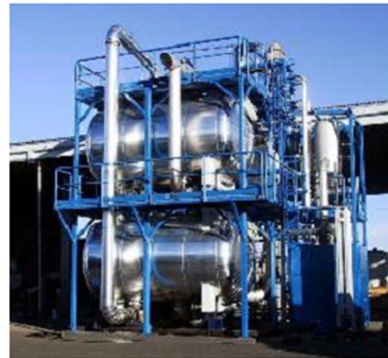
Batterie di filtri orizzontali
