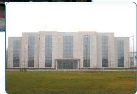
Industria grafica Padova 582kW in pompa di calore
