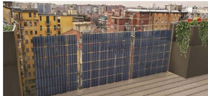
Per sistemi **parzialmente integrati** si intendono i moduli FV installati sia orizzontalmente che inclinati rispetto al piano copertura o con la stessa inclinazione di un tetto spiovente sottostante. Questa categoria era indirizzata alla maggior parte del patrimonio edilizio esistente, situato in città storiche dove sono presenti solo installazioni di retrofit consentito (cosiddetto **BAPV, Building-Attached Photovoltaics**).
