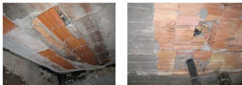
Figura 1. Solaio sfondellato
