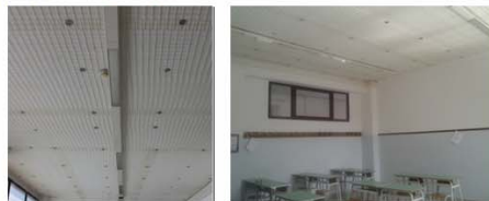
Figura 2. Sistema FIBREBUILD LIFE+ - ANTISFONDELLAMENTO
