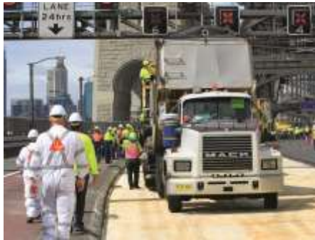
Ripristino e rinforzo cls
