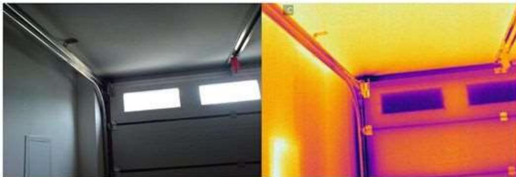
La potenziale formazione di punti di rugiada con conseguenti muffe o semplicemente l'eccessiva permeabilità all'aria declassa l'ambiente.
