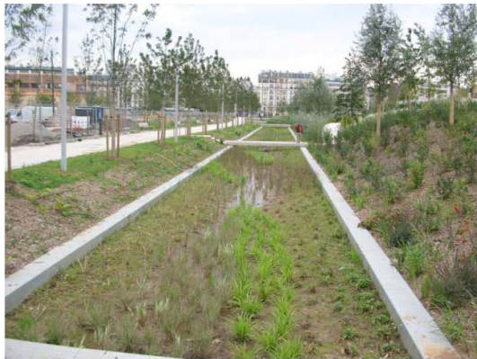
. I canali infiltranti, in questo caso inverditi, se realizzati nello spazio pubblico, possono divenire elementi di riqualificazione legati anche alla fruizione e al tempo libero (foto: Parc Clichy, Parigi)
