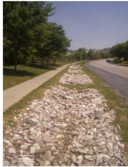
. Esempio di canali infiltranti_ http://sustainablestormwater.org
