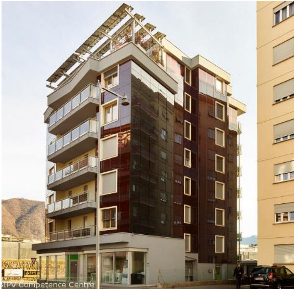
I sistemi da **fonti rinnovabili** possono essere **integrati nell'involucro** e sostituire componenti edili tradizionali (rivestimento di facciata, schermature solari, balaustre, etc) anche nel caso di retrofitting (Chiasso, 2012).
