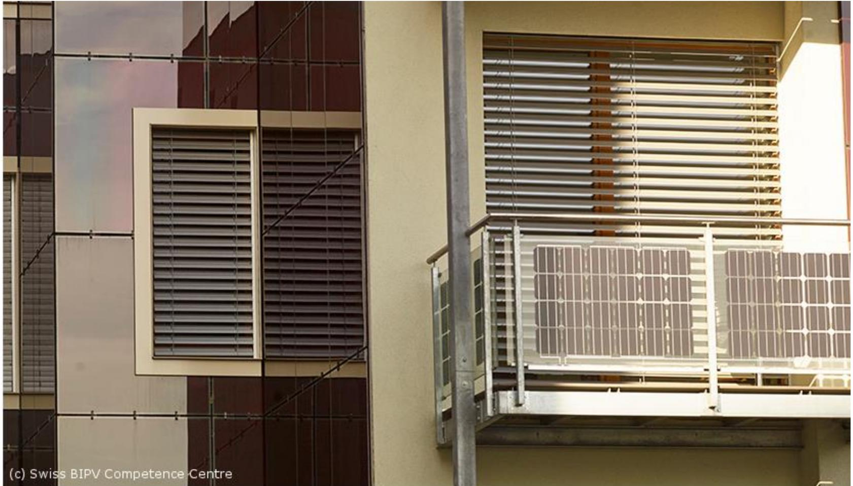
Facciata rivestita con pannelli colorati di silicio amorfo e celle fotovoltaiche integrate nella balaustra vetrata di un balcone (Chiasso, 2012).
