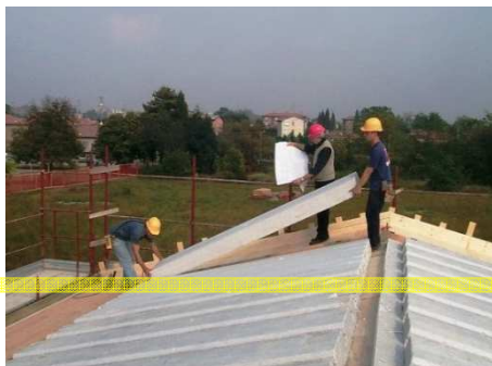
POSA DEI PANNELLI
