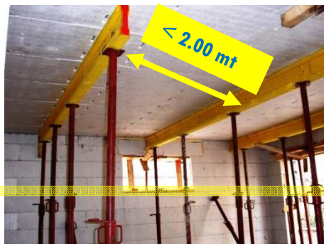
BANCHINAGGIO INFERIORE
