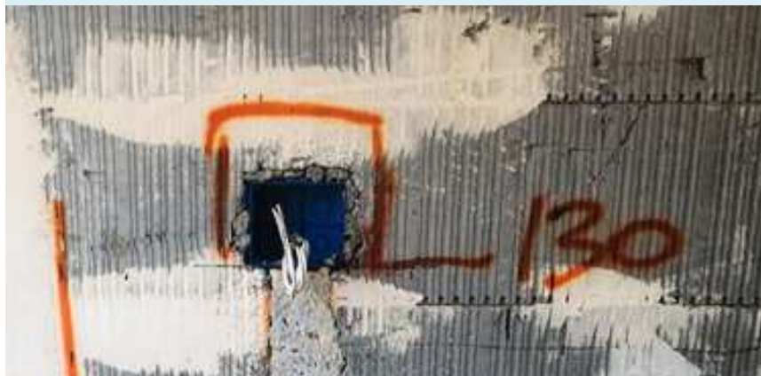
Realizzazione delle tracce e scatole di derivazione
