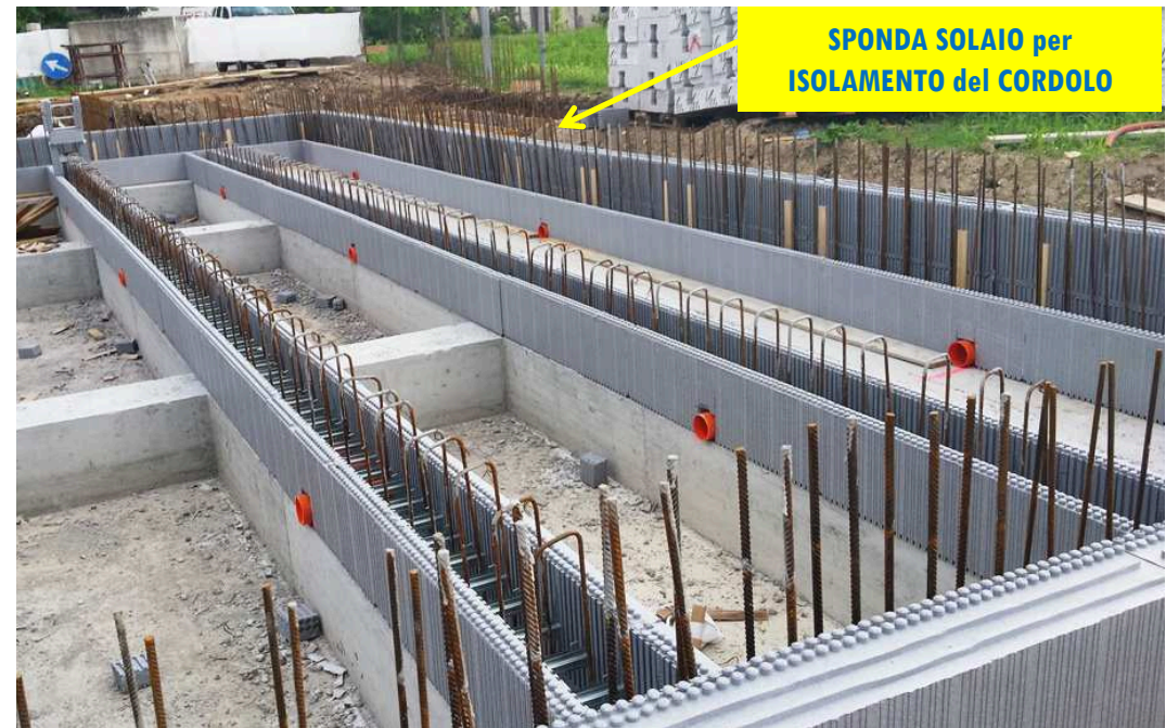
Banchine con casseri ARGISOL
