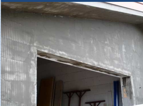
1. Primo strato di rasante
