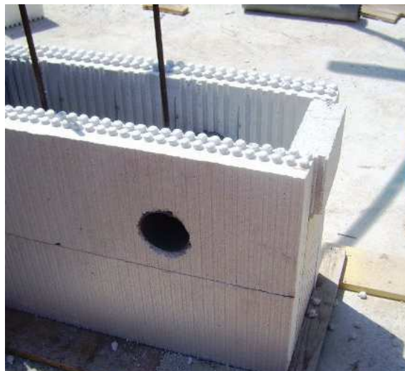
TUBAZIONI VERSO L'ESTERNO (predisposizione prima del getto di calcestruzzo)
