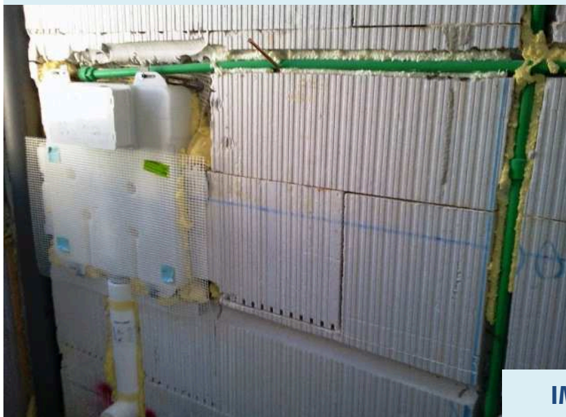
TUBAZIONI VERSO L'ESTERNO (predisposizione prima del getto di calcestruzzo)
