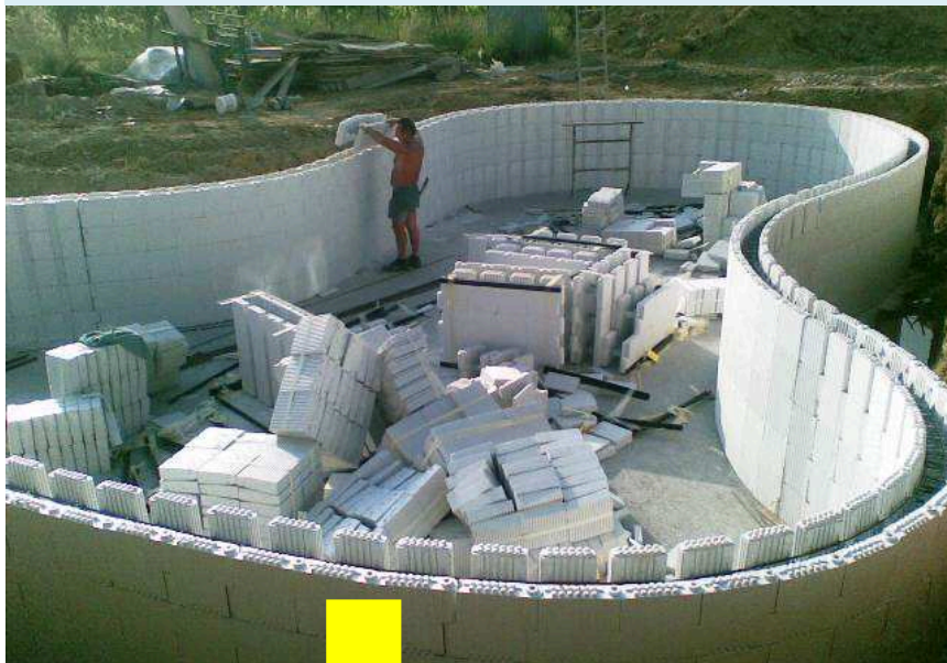
Piscina – San Giorgio di Nogaro (UD)
