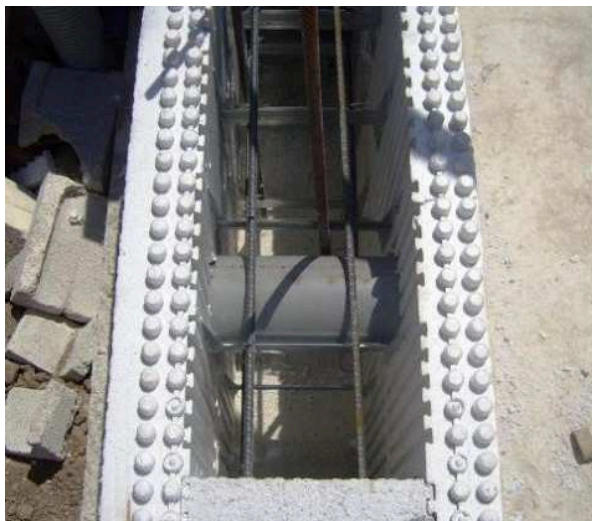
TUBAZIONI VERSO L'ESTERNO (predisposizione prima del getto di calcestruzzo)
