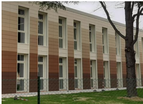
“Antonio Brancati”, Pesaro, LEED Platinum
