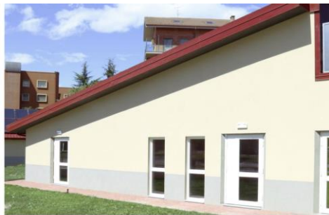
Il giardino direttamente collegato alle aule didattiche.
