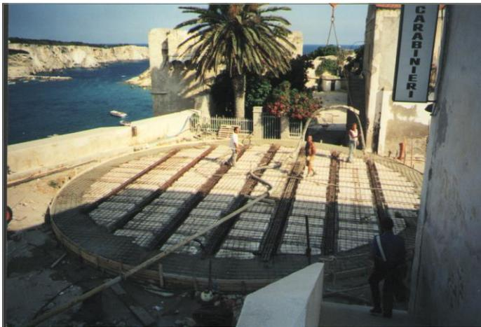
La struttura di copertura del pozzo realizzata in travi REP (travi miste acciaio-calcestruzzo) sulla quale verrà poi ripristinata la pavimentazione della piazza.
