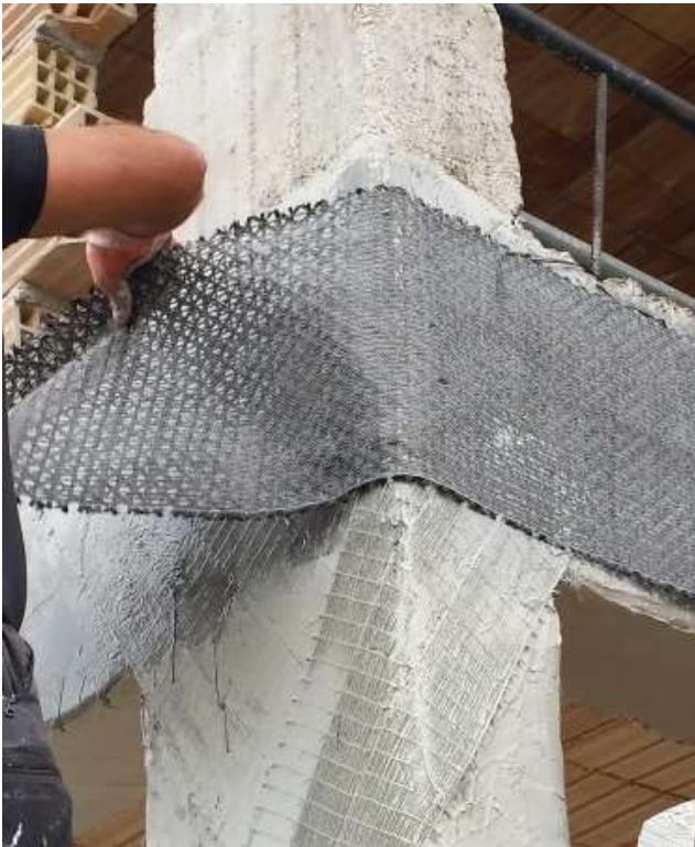
RINFORZO NODO D'ANGOLO IN CFRP
