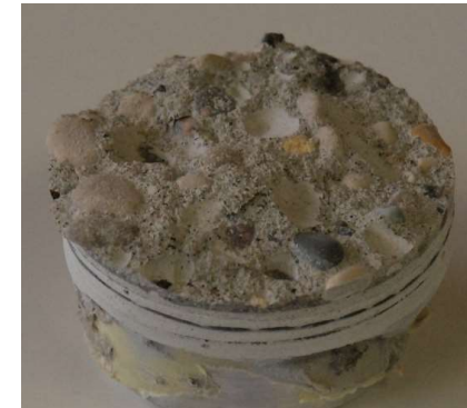
Il provino a prova completata (rottura del supporto in cls → OK!)
