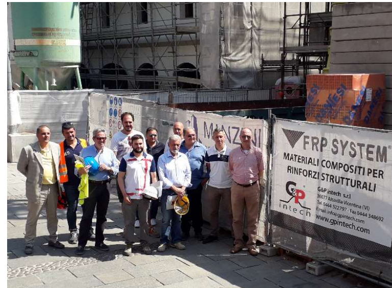
Visita di professionisti al cantiere Palazzo della Ragione di Mirandola (MO)- sisma 2012
