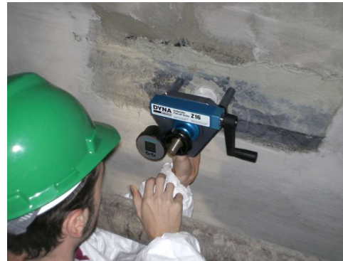
La fase di prova
