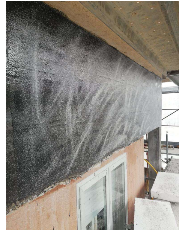
FASCIA DI PIANO IN CFRP
