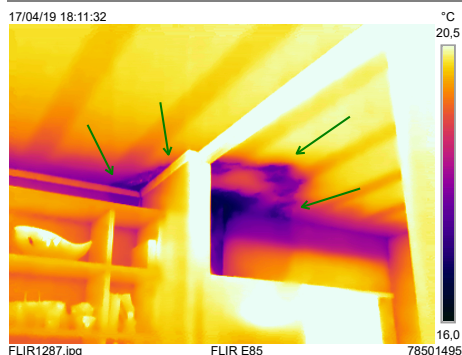
FLIR1287.jpg FLIR E85 78501495
