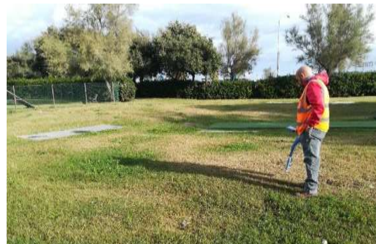
Ricerca cavidotti con Localizzatore Elettromagnetico
