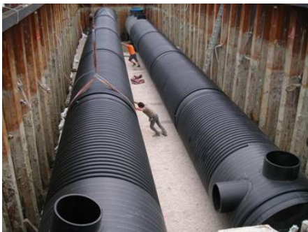
m 3 75 - DN 2000 mm Urbania (PU) 2018
