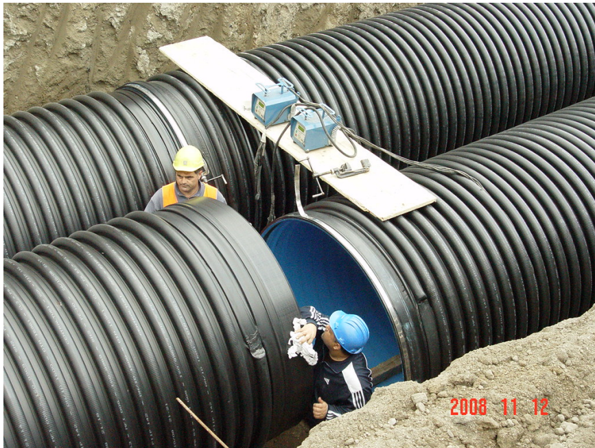
saldatori specializzati in cantiere
