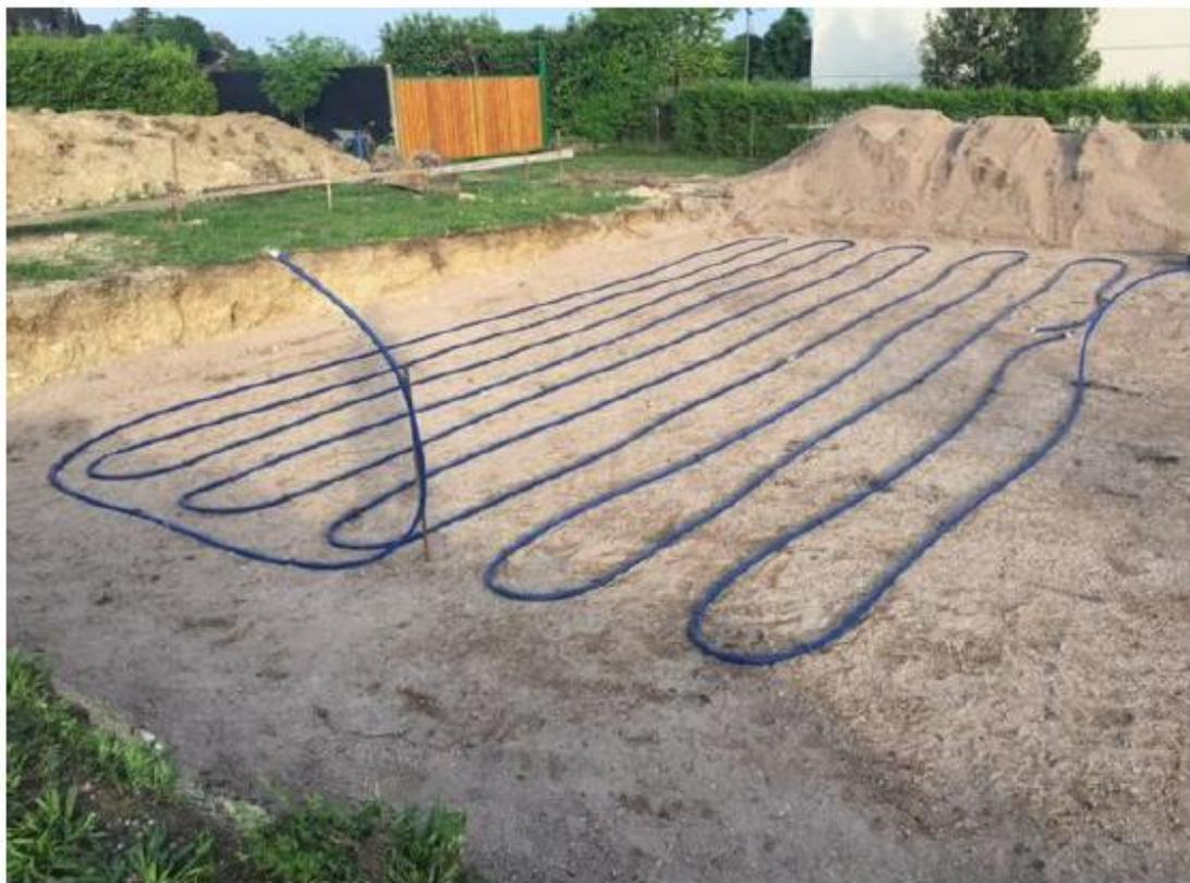
figura 12: POSA TUBAZIONE GEOTERMICA SU LETTO DI SABBIA
