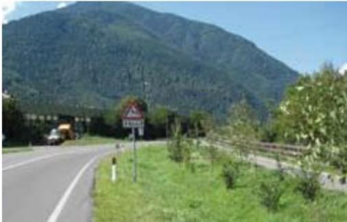
Fosso di infiltrazione lungo Via Brennero a Varna
