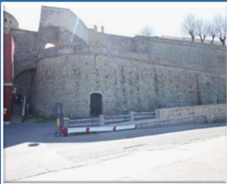
Risanamento conservativo muratura Rampe Romano
