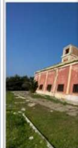
Foto complesso da demolire lato
