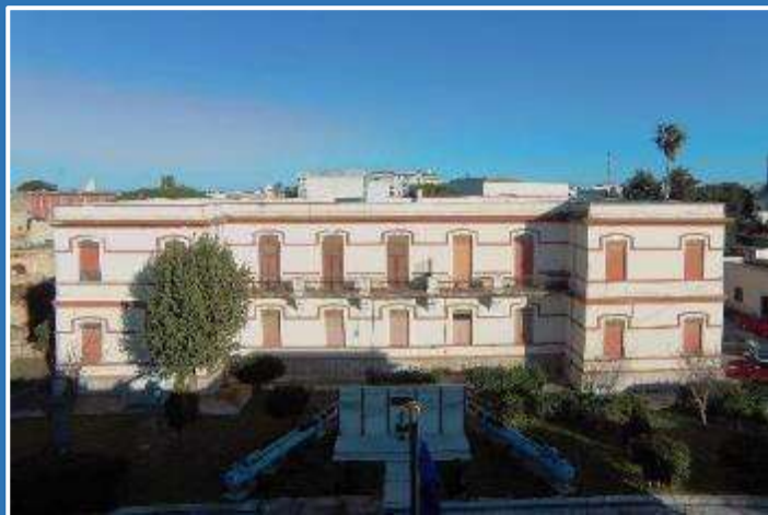
Miglioramento sismico e ristrutturazione Palazzina ex Medici
