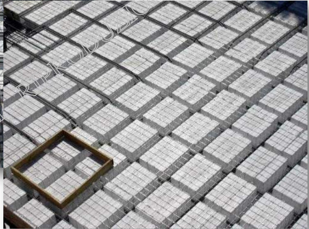
Solaio bidirezionale ad armatura incrociata
