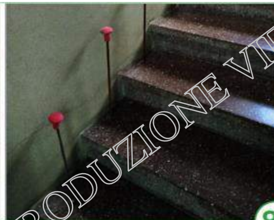
Posa delle armature in corrispondenza di terrazzi e scale
