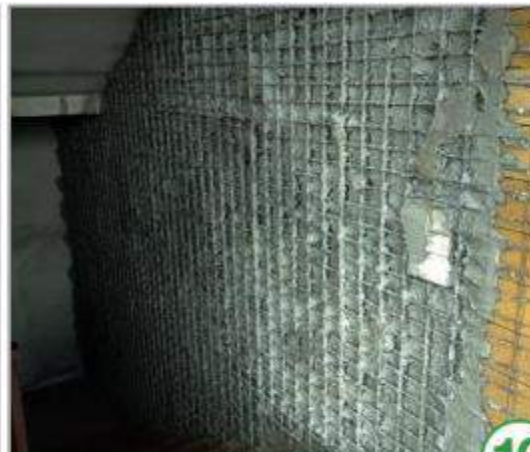
Pannello con calcestruzzo spruzzato per applicazione interna
