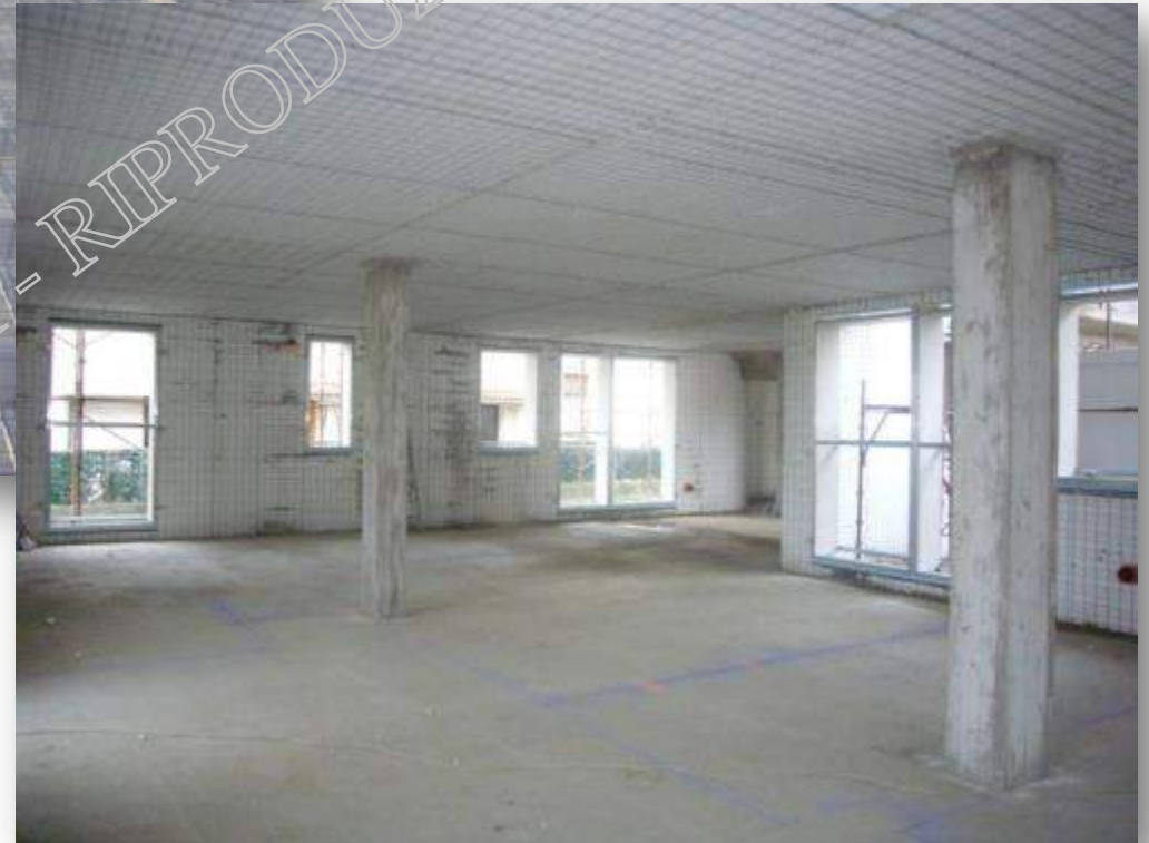
Soffitto con rete porta-intonaco
