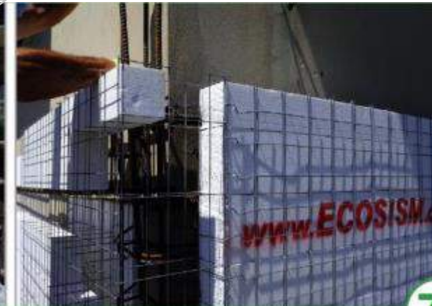
Posa delle armature orizzontali e verticali
