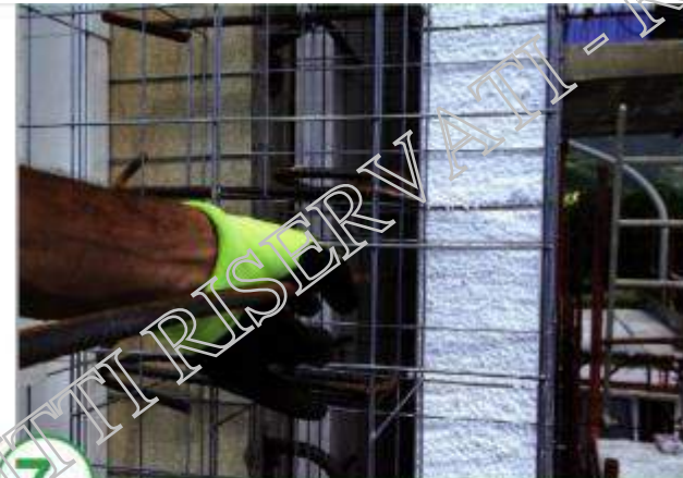
Posa delle armature orizzontali e verticali
