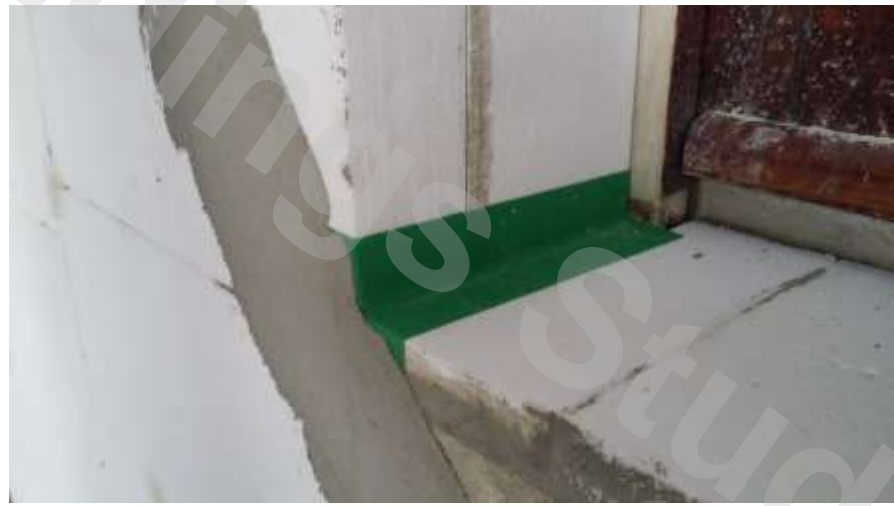
Giunti con altri componenti dell'involucro: Al fine di evitare l'ingresso di aria fredda, ma consentire movimenti differenti alle varie parti, verranno adoperati particolari nastri espandenti.
