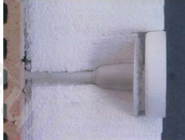
Tassello a bassa conduttività con aggiunta di tappo copritassello per l'abbattimento del ponte termico puntuale.
