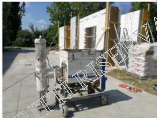
Figura 4.19. Getto di completamento
