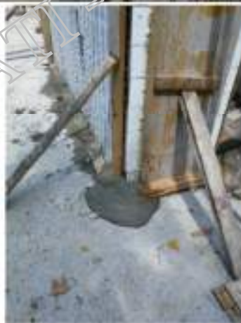
Figura 4.18. Posa dell'armatura
