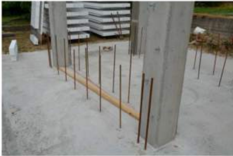
Figura 4.15. Chiamate in fondazione
