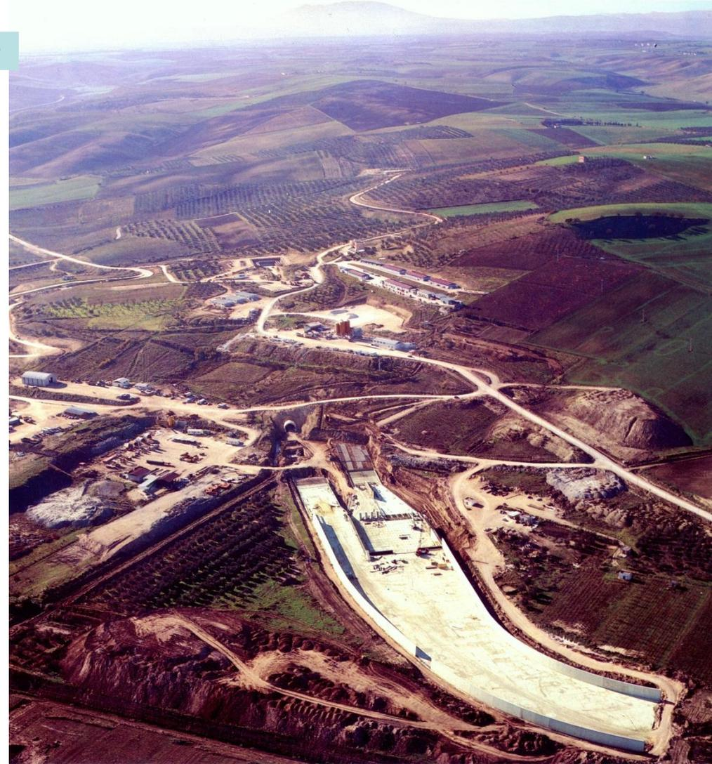
Il canale fugatore, la vasca di dissipazione con il canale di scarico e lo sbocco dello scarico di fondo, visti da valle. Sullo sfondo il Vulture.
