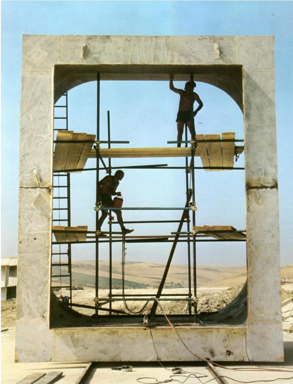
*Preassemblaggio di un elemento metallico per il blindaggio delle paratoie.*
