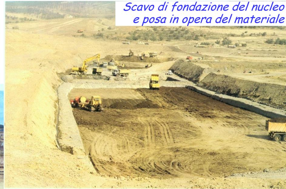
Scavo di fondazione del nucleo e posa in opera del materiale.
