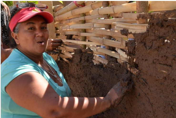
Nicaragua ' taquezal ' : Una muratura realizzata con fibre di pannocchie a "doppia orditura"
