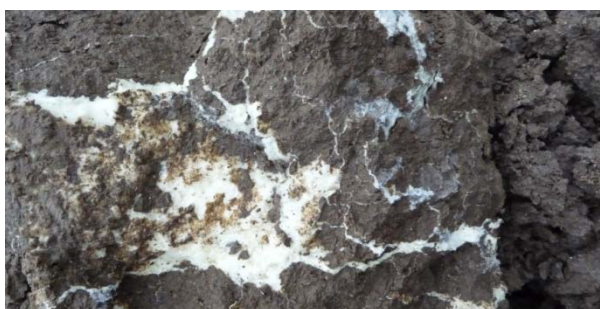
Figura 1 – Terreno consolidato con resina.
