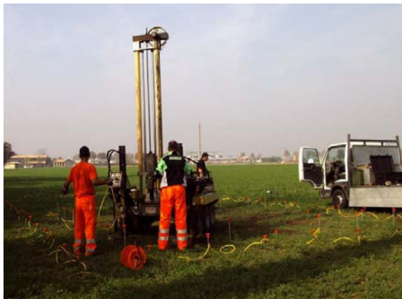
Figura 33 – Fase di esecuzione della prova CPTU.
