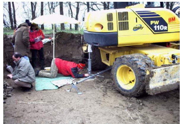
Figura 25 – L'equipe dell'Università degli Studi di Milano durante l'esecuzione della prova di carico su piastra.
