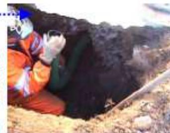
Dopo aver parzialmente riempito lo scavo, è stato posizionato il pozzetto in calcestruzzo con la funzione di ospitare un ventilatore da 65 W canalizzato alla tubazione.
