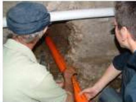
Nel tratto terminale della canalizzazione è stato inserito un ventilatore da 70 W, che tramite un tubo di raccordo espelle il gas tramite una finestrella a bocca di lupo.
