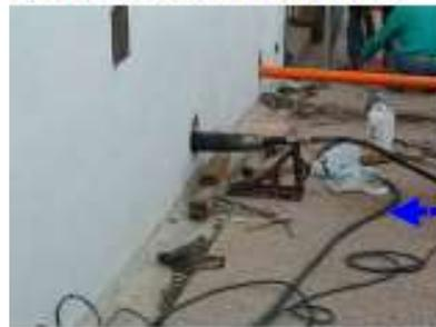
Con uno speciale perforatore usualmente impiegato nella realizzazione di sottoservizi sono stati eseguiti due fori orizzontali a partire dalle bocchette di ventilazione.
