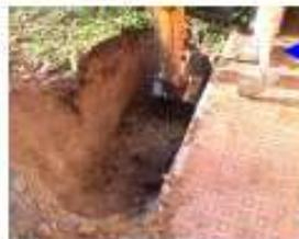
Questa operazione ha messo in evidenza la presenza della resina consolidante, e pertanto è stato possibile individuare un punto idoneo per la realizzazione di un foro orizzontale a profondità di circa 1.20 m che intercetti solo il terreno naturale., in modo tale da raggiungere il limite della fondazione.
