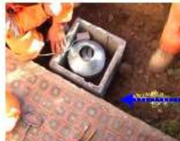
È stato quindi completato il riempimento dello scavo e la rifinitura per un'adeguata protezione del ventilatore.
