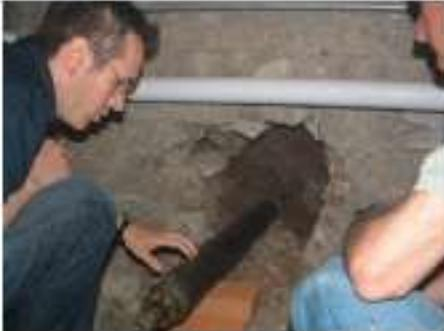
Dalle due pareti controterra della cantina, ad un'altezza di circa 15 cm dal pavimento, sono stati eseguiti due fori orizzontali con un perforatore usualmente impiegato nella realizzazione di sottoservizi. La profondità raggiunta è stata di 2 m intercettando materiale di riporto sciolto.
