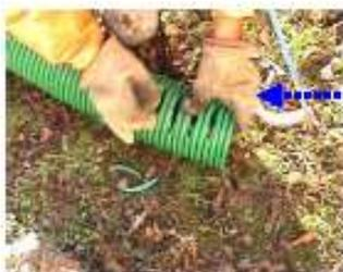
È stato quindi preparato il tubo di aspirazione, usando un tubo microforato flessibile, avendo cura di ampliare ulteriormente i fori nel tratto terminale.
