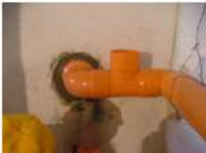
L'intero impianto è stato quindi raccordato con una tubazione in PVC e nei pressi del primo foro è stato canalizzato un ventilatore da 70 W che espelle il gas intercettato dalla finestrella posizionata subito sopra.
