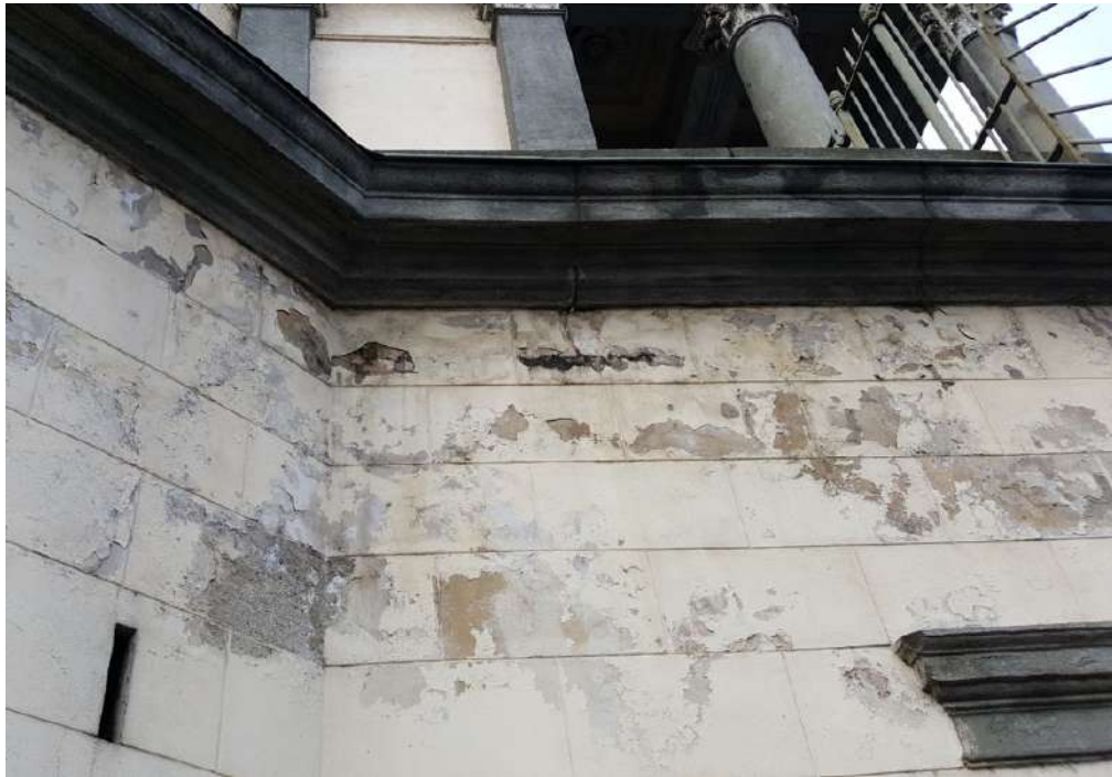
Distacco di porzioni d'intonaco a causa di infiltrazioni d'acqua.
