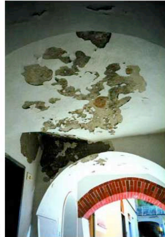
Distacco di porzioni d'intonaco a causa di infiltrazioni d'acqua.
