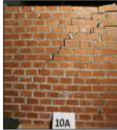
PANNELLI 9-10 Non rinforzati
