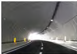
Figura 1. Rivestimento concluse le lavorazioni
