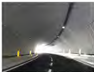
Figura 1 - Rivestimento concluso le lavorazioni
