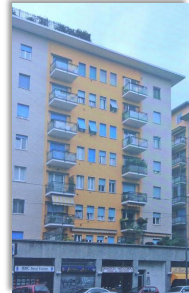
Manutentore: Ferraris Energia
