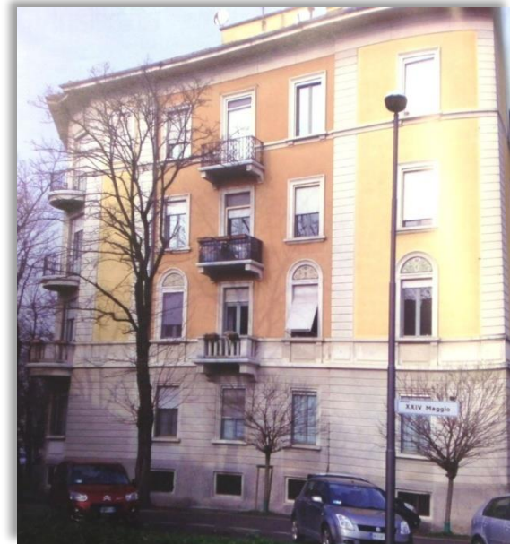
Manutentore: Termica Servizi
