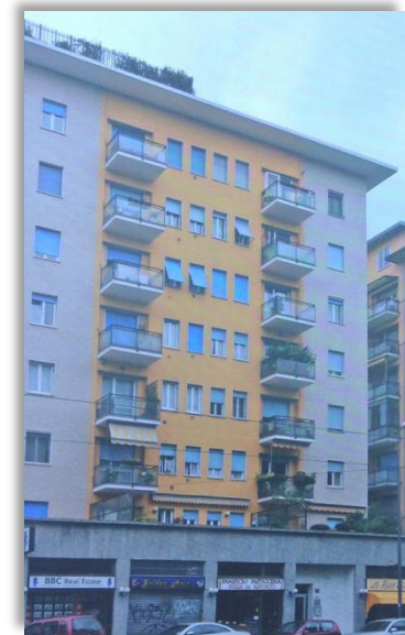
Manutentore: Ferraris Energia
