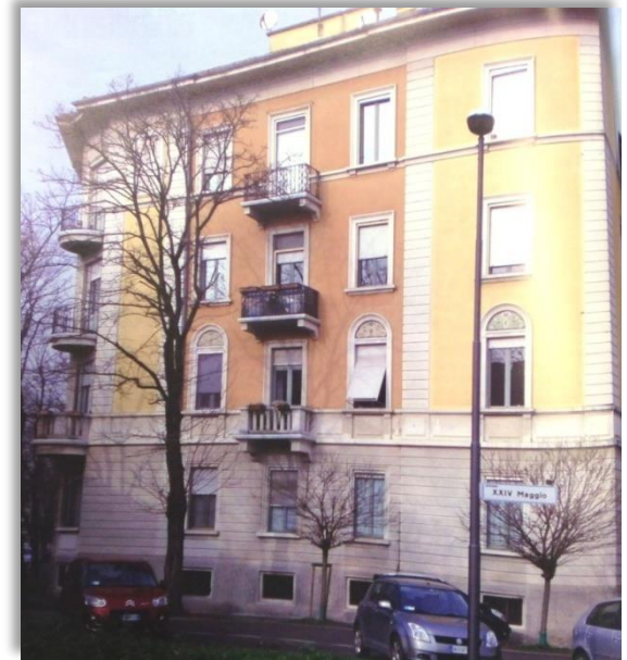
Manutentore: Termica Servizi
