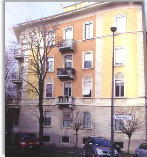
Manutentore: Termica Servizi
