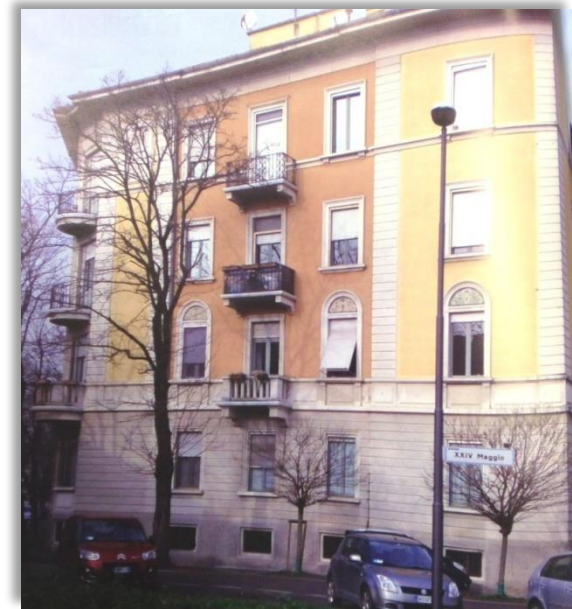
Manutentore: Termica Servizi
