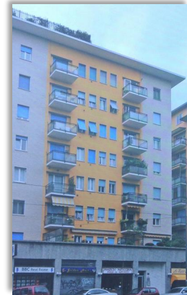
Manutentore: Ferraris Energia
