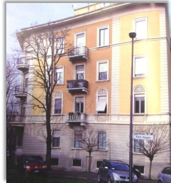
Manutentore: Termica Servizi
