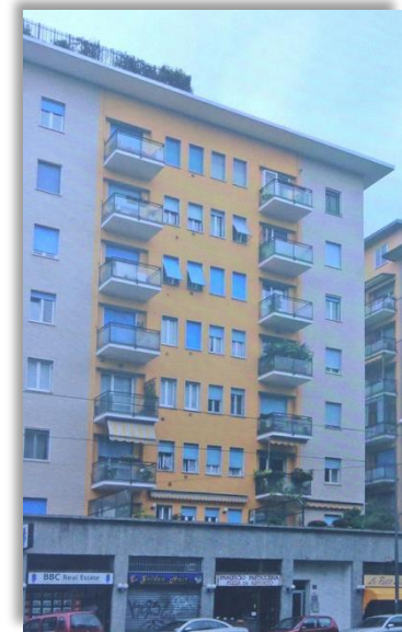
Manutentore: Ferraris Energia
