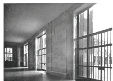
SERRAMENTI IN FERRO NEL PALAZZO DELLE POSTE, A BRESCIA
