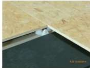
Pose des panneaux / Pose of panels OSB
