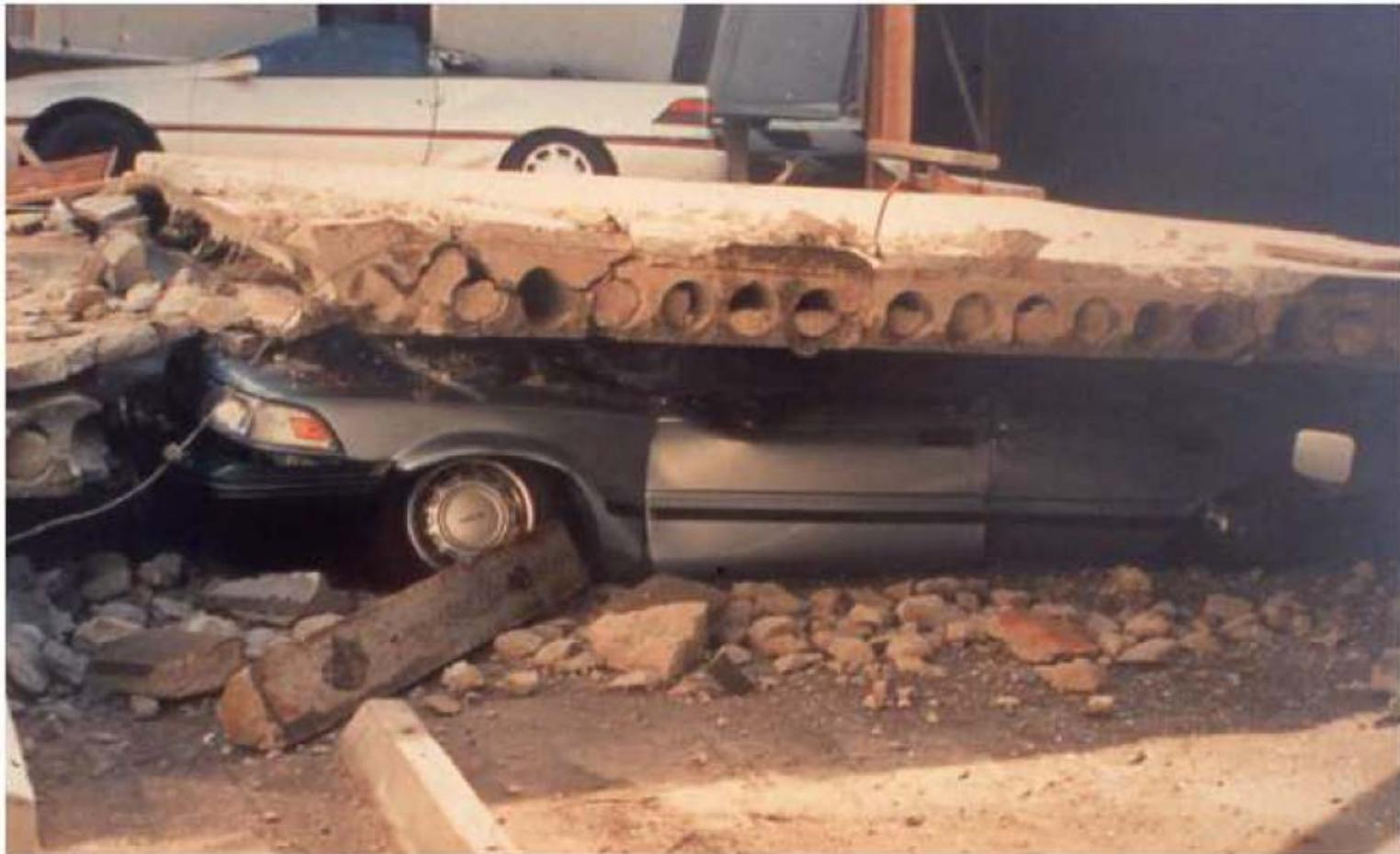
Figura 4: Crollo dell'impalcato per carenza di collegamenti Northridge 1994 (FIB. Bull. 27)
