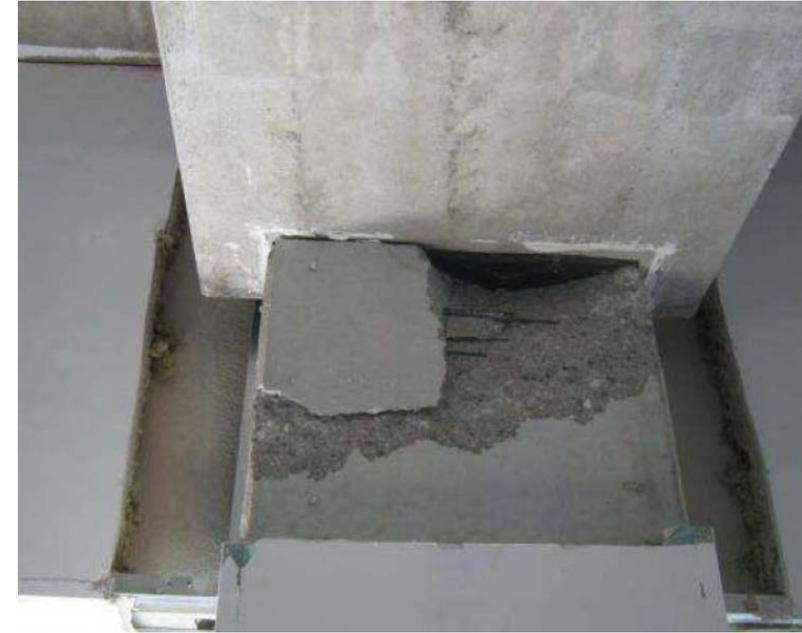
Figura 9: L'Aquila 2009: Lesioni verticali alle selle di appoggio alla connessione trave/pilastro (Reluis 2009)
