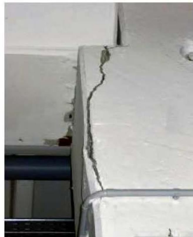
Figura 7: L'Aquila 2009: Rottura del copriferro in adiacenza agli spinotti (Faggiano et. Al 2011)
