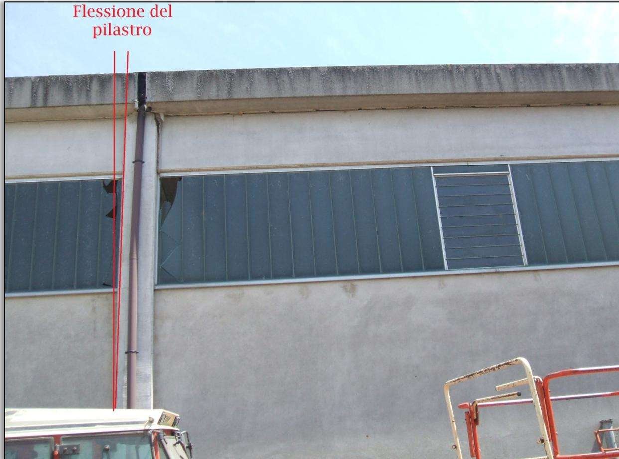
I pannelli di tamponamento possono anche interagire in modo deleterio con le strutture portanti creando effetti particolarmente critici sulle colonne.
