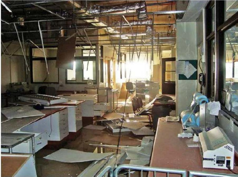
Figura 20: Elementi non strutturali - Collasso controsoffitti (Cile 2010)
