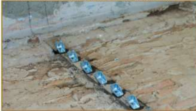
Connettore non industrializzato (tipo sistema "Turrini-Piazza")
