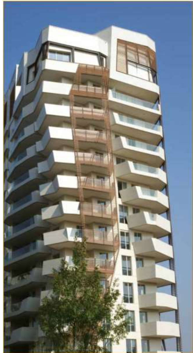
Edificio pluripiano con elementi in aggetto (parapetti) e struttura portante di sommità (piano attico e superattico) in calcestruzzo leggero strutturale (CityLife Milano).
