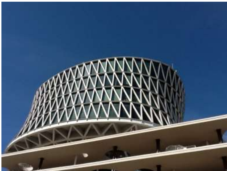
Torre di Fuksas (Pescara)
