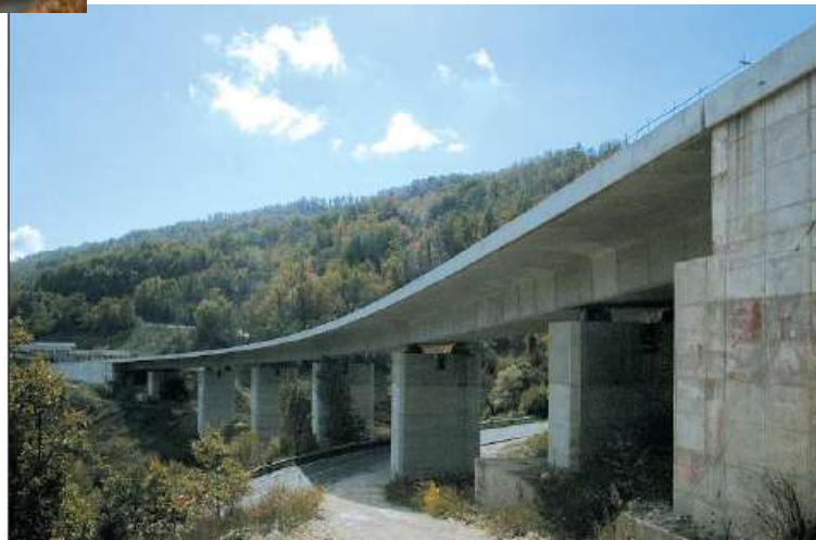
Viadotto S.S. Isernia Castel di Sangro (AQ)
